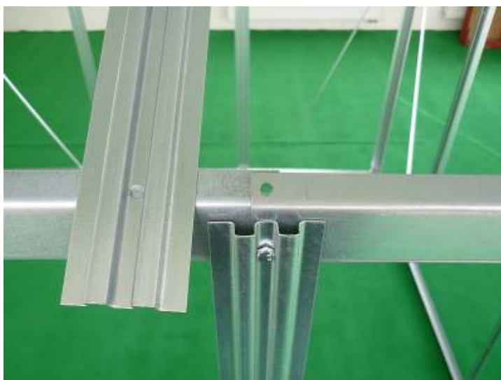
Montáž střešních sloupků (poz. 15, 5, 10) střešní sloupky přichytíme také k střešnímu plechu.
