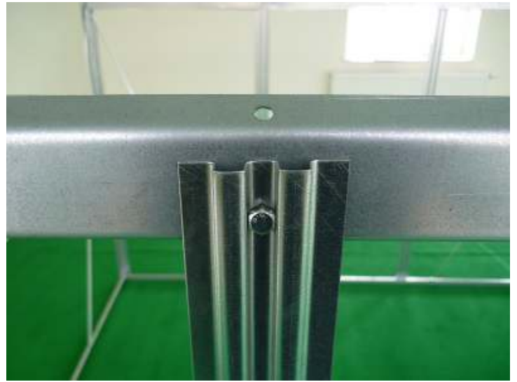
Dále přichytíme boční sloupky ke střešnímu plechu (5). Takto sloupky namontujeme po celé délce skleníku.
