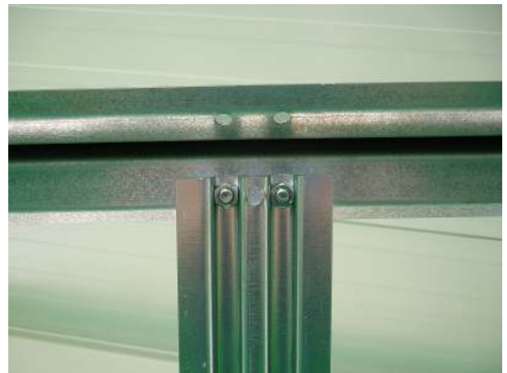
Dále přichytíme boční sloupky ke střešnímu plechu (5). Takto sloupky namontujeme po celé délce skleníku.
