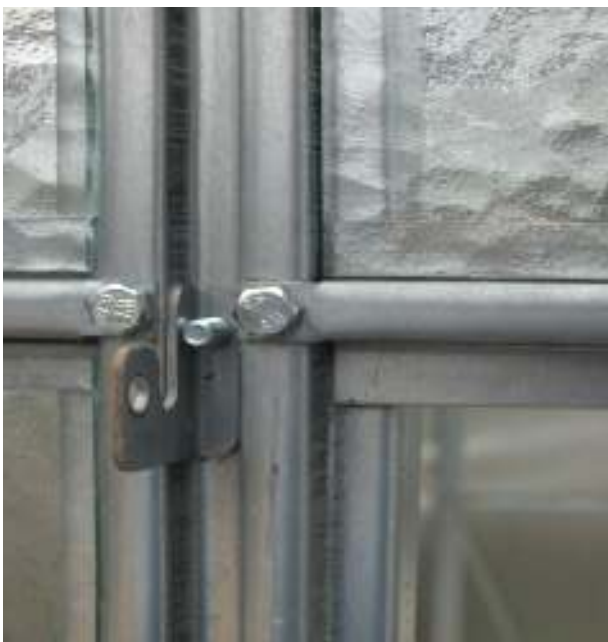
Detail umístění závěsů na sloupek čela (poz. 7).
