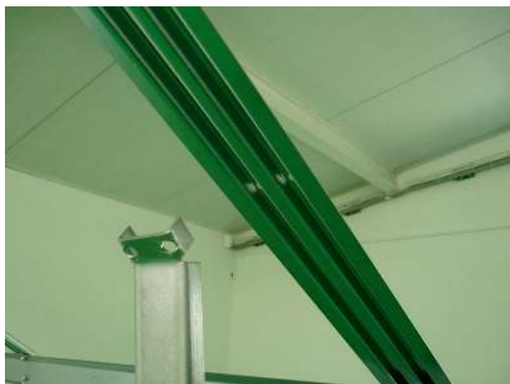
Spojení střešní výztuhy (24) a střešního sloupku (15).
